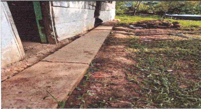
FOTO NO. 1 SE OBSERVA EL PISO DE LA COSINA EN MAL ESTADO, NECESITA SER SUSTITUIDO
