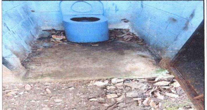
FOTO 2 SE OBSERVA EL PISO DE LOS BAÑOS ESTAN EN MAL ESTADO NECESITA SER SUSTITUIDA
