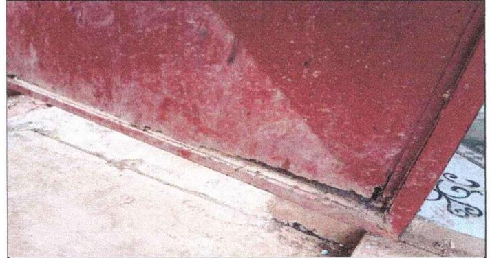
FOTO No. 4 SE OBSERVA LAS CUATRO PUERTAS EN MAL ESTADO NECESITA SER SUSTITUIDAS
