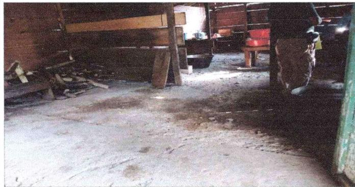
Foto 5: SE OBSERVA LA COCINA EN MAL ESTADO SE NECESITA CAMBIO DE PISO
